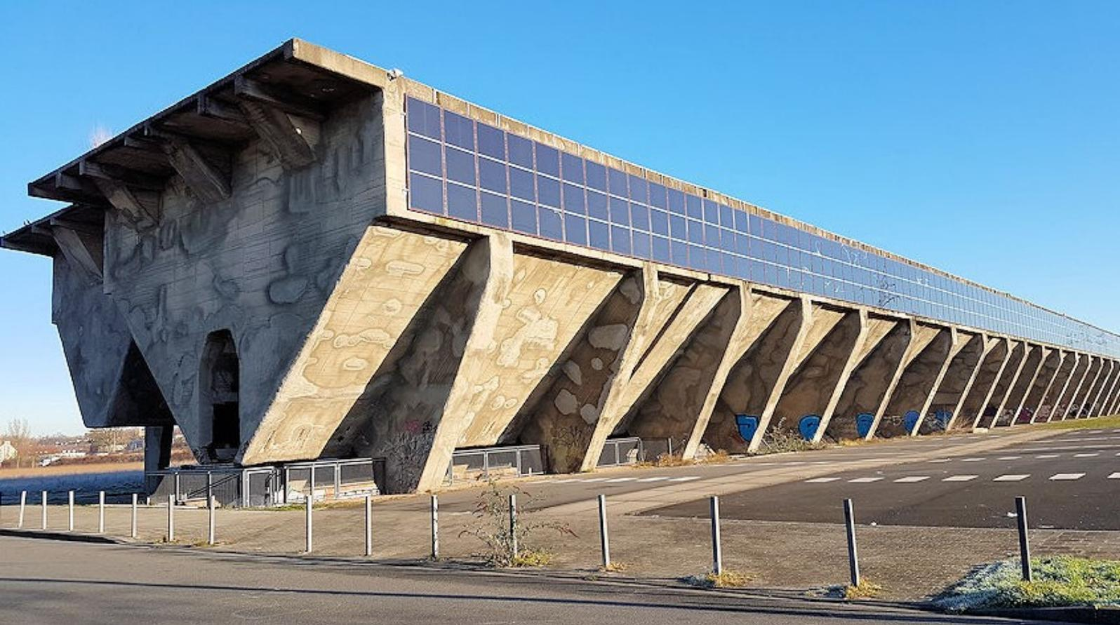
Bilder: Erhalten blieben in Gelsenkirchen Bulmke die 12 Meter hohen und 240 Meter langen Erz- und Kohlebunker des Unternehmens Schalker Gruben- und Hüttenverein, gegründet 1872, auf denen ein außergewöhnliches Solarprojekt realisiert wurde: mit dem Solarbunker Gelsenkirchen ging im April 2008 ein Solarkraftwerk in Betrieb, das jährlich ca. 320.000 kWh Strom erzeugt; EEZ Energie Energiewirtschaft Zukunftsenergien
